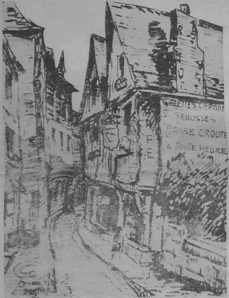
Rue du Petit-Fort.
