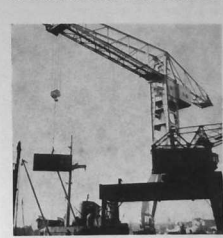
Port de Nantes : la grue de 60 t en opération de maintenance de conteneurs, quai Wilson.
