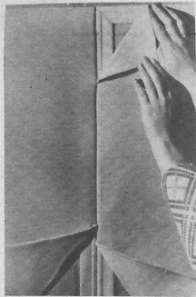
Pose d'un tissu skai mural en tendant les lés sur des bandes latérales accrochantes de la baquette, puis, pour former un joint parfait, en encastrant les bandes des lés dans la rainure centrale de la baquette.
