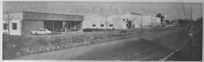
La rocade et la zone artisanale du Mée (photo Noël, Vitré)
