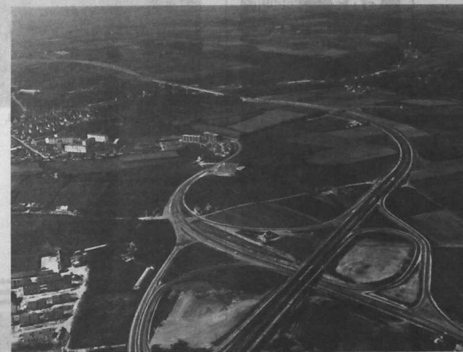
La déviation de Morlaix - côté est. Echangeur est - viaduc routier (Photo Heurtier - Rennes-Nantes)
