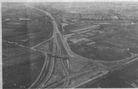
L'autoroute C 11 ou pénétrante Est, dont le premier tronçon reliant la Loire à la route Nantes-Paris a été mis en service en septembre. Ici, l'échangeur de la Madeleine sur la route de Paris.
