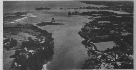
La Forêt-Fouesnant : vue avant travaux prise du nord au sud. — A : emplacement des immeubles collectifs prévus ; à cet endroit, toute construction masquerait l'échappée du bourg vers le large. — B : digue du XVI e siècle, classée. — C : partie du remblai de 22 ha où pourrait se situer la totalité d'une opération immobilière s'insérant dans le paysage (photo Yves Caudal).
