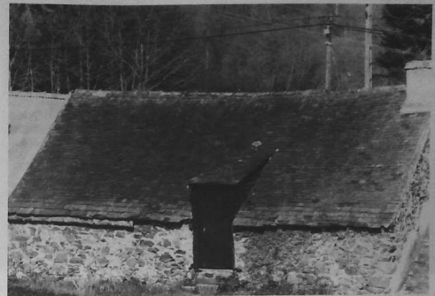
La maison rurale bretonne s'adapte au terrain en tirant au mieux parti des données naturelles. On a utilisé la pente contre laquelle s'appuie cette maison de Plourin pour faciliter l'accès au grenier par une porte à l'arrière.
