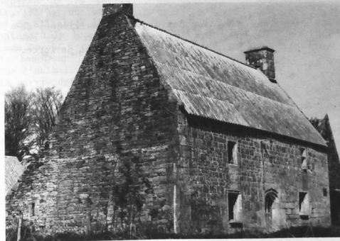
Maison à escalier extérieur à Poulfétan. La pierre saillante à droite de la fenêtre servait à accrocher l'échelle.
