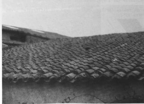
Au Sud de la Loire, les maisons sont recouvertes de tuiles "canal". La pente du toit est faible ( 30°)
