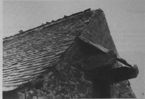
Toit d'une crèche à Goazmelcun en Plounéour-Ménez. On remarquera l'épaisse ardoise des Montagnes. Les plus petites sont réservées pour le haut du toit. Les ardoises du lignolet sont découpées. Peu subsistent car elles servent de cibles aux chasseurs. Les deux entrées sont protégées par un auvent en ardoise.
