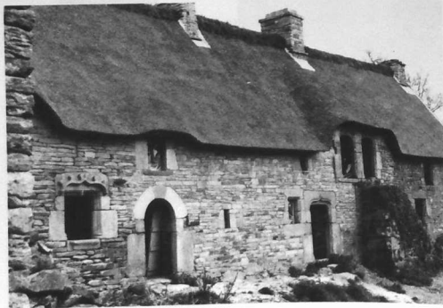
Maison à escalier extérieur à Poulfétan. La pierre saillante à droite de la fenêtre servait à accrocher l'échelle.
