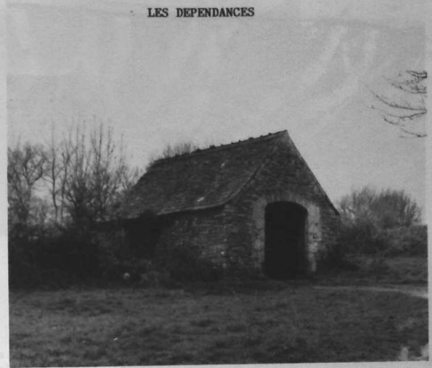
Les remises à grand portail pour permettre l'accès des charrettes par le pignon sont apparues en Bretagne vers 1750. Celle-ci se trouve dans un hameau proche de La Feuillée. On remarquera le lignolet découpé.
