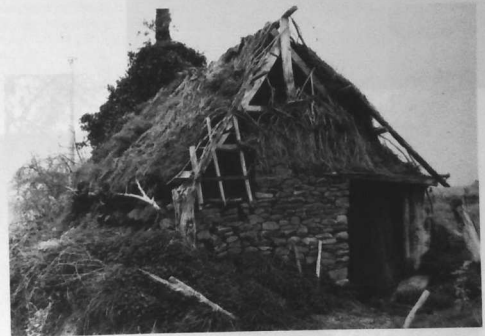
Cette crèche a été construite sans pignon élevé. Elle est appuyée au talus. Les techniques de construction sont ici rudimentaires (Poullaouen).
