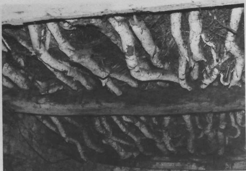
On rencontre souvent dans les granges un plancher à l'étage formé de branches et de branchages entrecroisés et reposant directement sur les poutres. Ce plancher convient pour paille et foin. (Sizun). Ce four, à Saint-Rivoal, est une construction indépendante. La voûte de pierre est couverte de terre et l'entrée protégée par un auvent d'ardoise.
