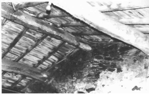
La charpente dans le vignoble nan- tais. La couverture repose sur cinq poutres scellées dans les pignons.
