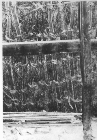
Le chaume dans cette ancienne maison de Quistinic est fixé à un clayage vertical.
