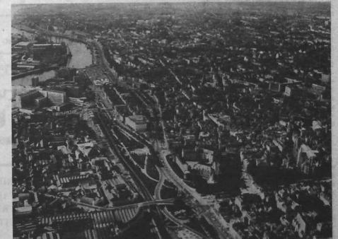
Au premier plan, l'échangeur de la place de la Duchesse-Anne, prolongé par la square Elisa-Mercœur. Au centre, le château. A droite, la cathédrale. Au fond, l'ancienne île Feytaud, magnifique ensemble architectural du XVIII e siècle, prolongé à l'est par l'immeuble-parking Neptune et, à l'ouest, par un immense parking gratuit de 1 200 places.
