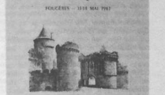
14 mai 1961 : aux portes de la Bretagne.
