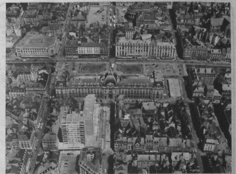
Vue aérienne du centre de Rennes (photo Heurtier).
