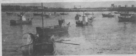
Le port du barrage d'Arzal (photo Alain de Bergevin).
