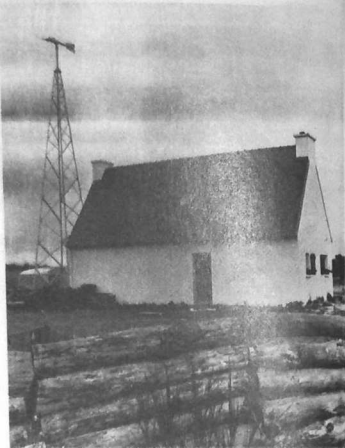
éolienne à Kermathéano près de Plomeur
