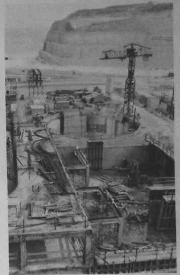
chantier de la centrale de Paluel
