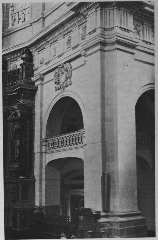
Fig. 13. - Travée droite du chœur et oratoire, côté Sud.
