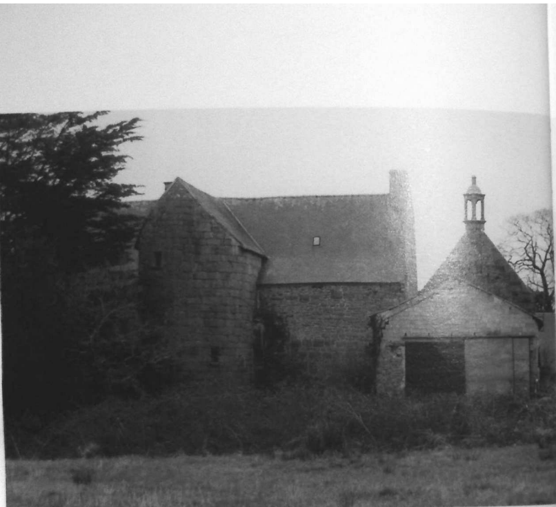
La tour d'escalier avant travaux. Photo de Janine Cotten.
