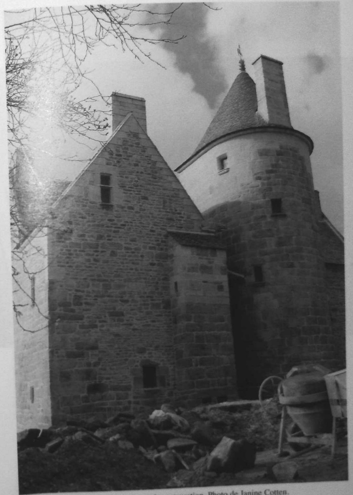
La tour d'escalier après restauration. Photo de Janine Cotten.
