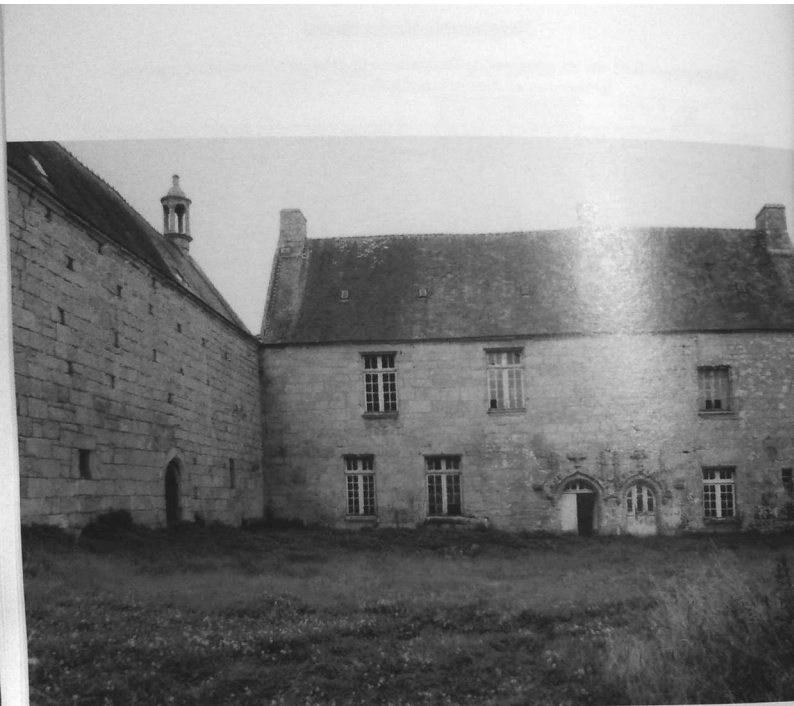
Le manoir, longère sud : avant travaux. Photo de Janine Cotten.
