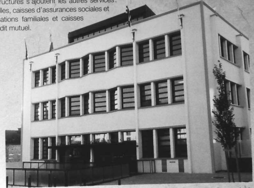
Bâtiment de l'Office central appelé « Maison carrée ». Cliché V.D.L. Service Communication
