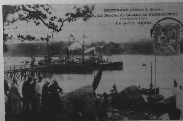
Le petit quai de St-Jean qui s'effondra en 1890.
