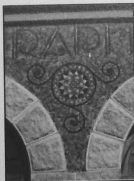
Détail de la façade
