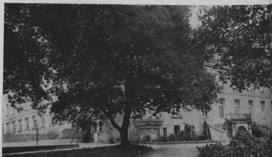
Nantes-Chantenay Ecole Notre-Dame-de-l'Abbaye Vue de l'entrée principale
