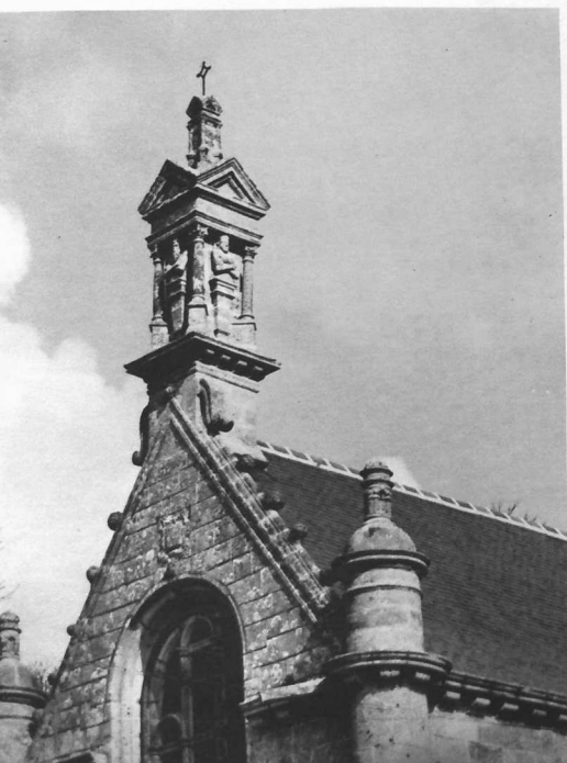
Façade méridionale du transept.
