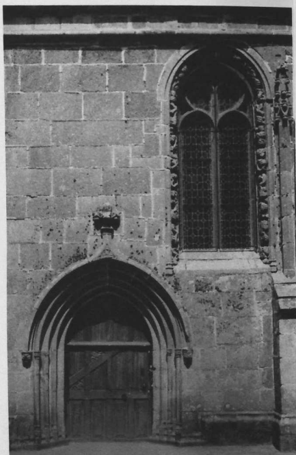
Fenêtre remarquablement sculptée extérieurement et intérieurement d'une guirlande de vigne.
