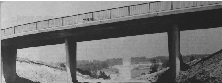
Lamballe - la déviation de la R.N. 12 en cours de construction (photo Alain de Bergévin)
