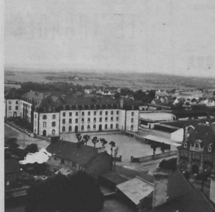
Du haut du clocher, vue partielle sud-ouest — Au premier plan, l'école primaire ; au second plan, l'hôpital.
