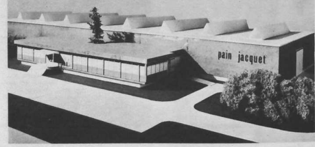
La future usine du pain JACQUET à Lamballe. (Photo Baranier.)
