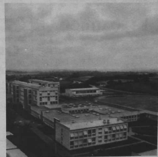
Du haut du château d'eau, vue est du lycée — Un nouveau C.E.S. de 1200 places lui sera bientôt annexé.
