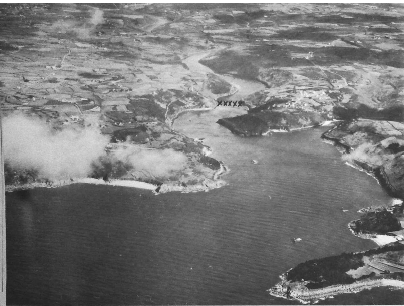
Indiqué par des croix, le barrage prévu pour l'aménagement du port. (Photo C.N.E.T. - D. E. V. L.)
