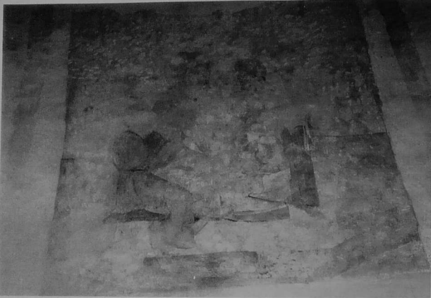
Photo. 7 : « Le repas à l'auberge d'Emmaüs » sur le 2ème arcade du mur sud ; état actuel après restauration (cliché : A. Tarière, 1992).
