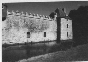
Au début du XVII ème , à l'ouest le renforcement du mur d'enceinte terminé par un pavillon permet de voir les larges douves remplies d'eau. (© Maryvonne Couédo)
