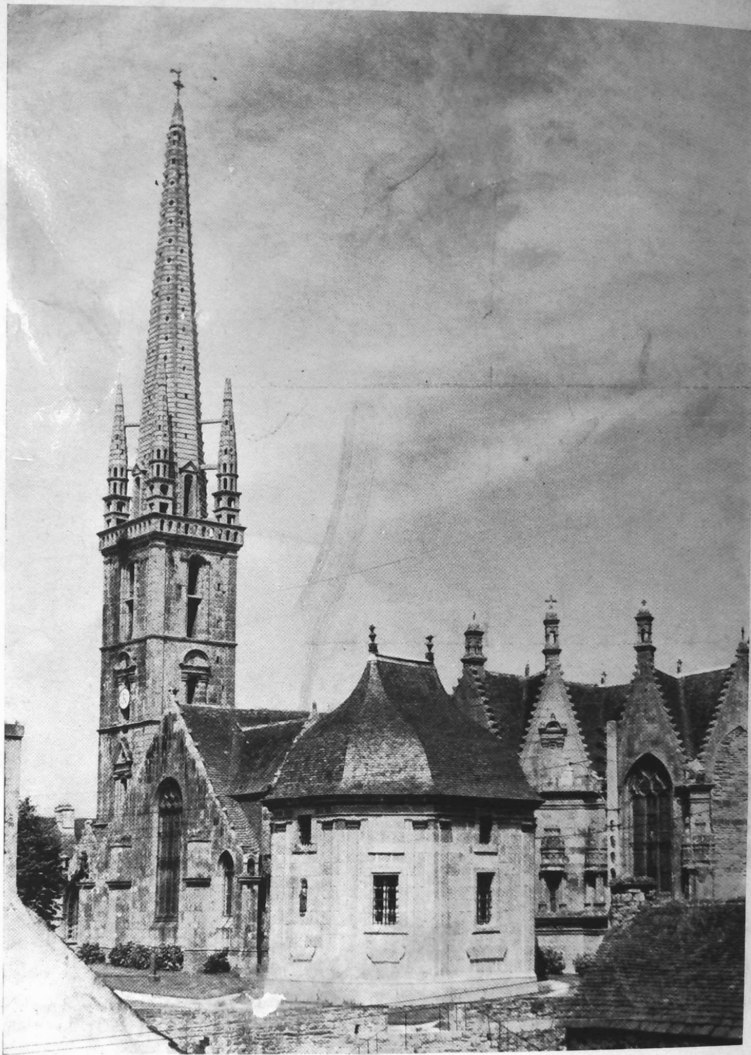
« La sacristie du XVII e siècle ajoute à l'ensemble une note élégante, voir maniérée, avec sa toiture en ardoise, de forme carénée. »
