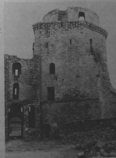
Le DONJON MILITAIRE, et à gauche l'entrée, côté cour, surmontée par la salle des manœuvres du pont-levis ; multiples ouvertures, un nœud important de circulation
