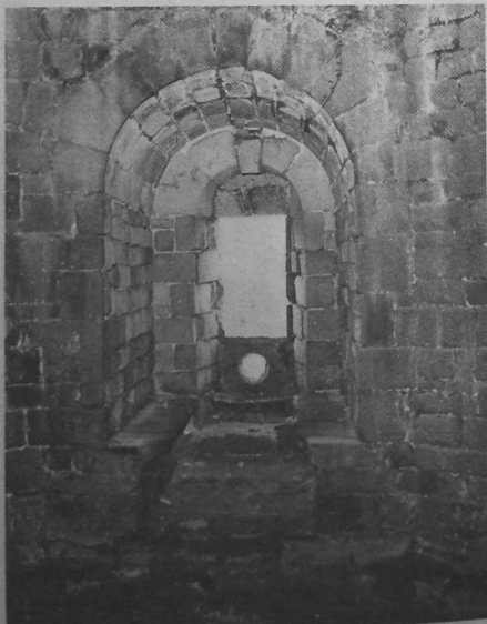
CANONNIERE CIRCULAIRE, vue de l'intérieur
