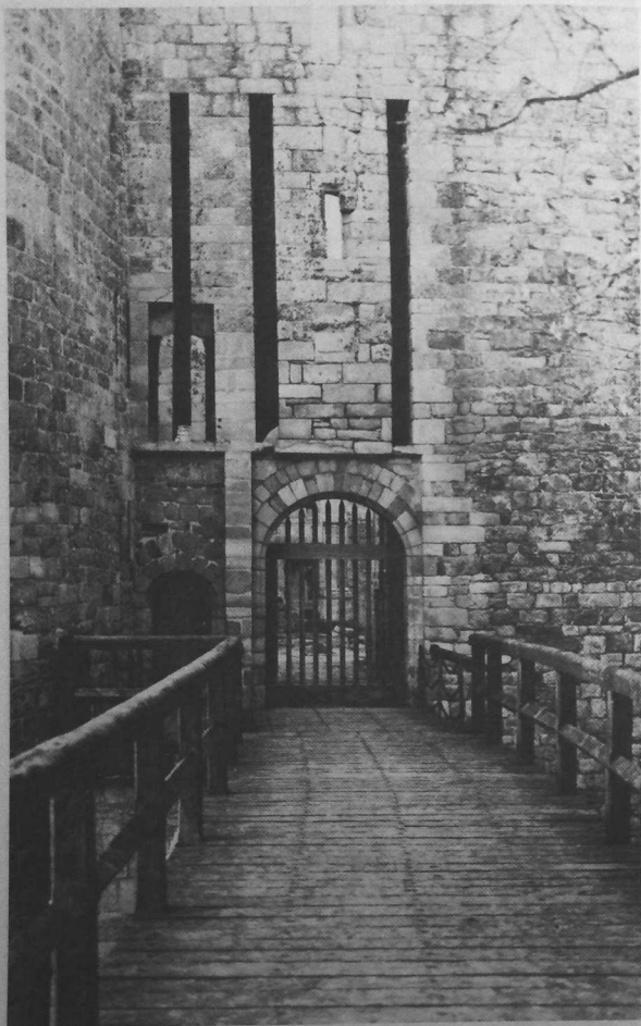
LE PONT-LEVIS : défendu à gauche par le donjon militaire à partir de ses archères d'angle percées dans la cage de son escalier
