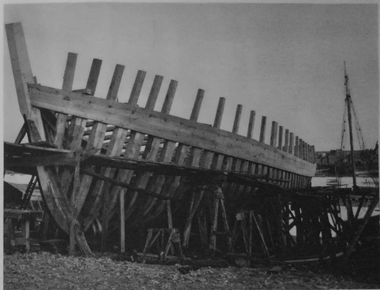
CAMARET. CONSTRUCTION D'UNE BARQUE.
