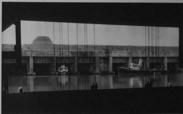
SAINT-NAZAIRE. ALVÉOLES DE LA BASE SOUS-MARINE.
