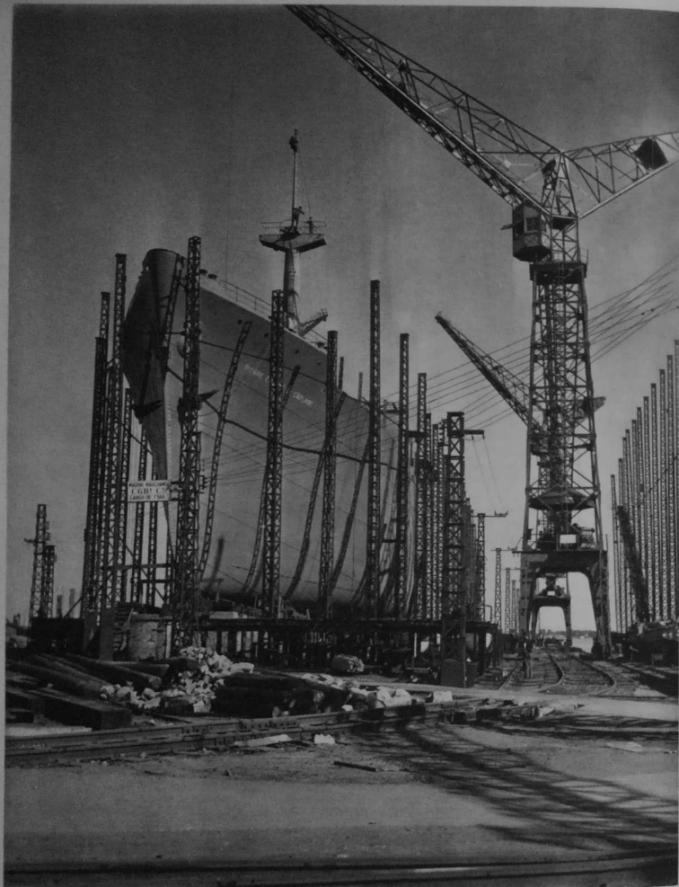
LES CHANTIERS DE PUNHOËT.
