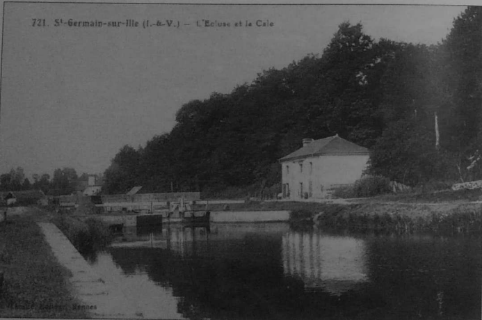
Vue du début du 20 ème siècle. Les balanciers des portes sont blanchis. Les passerelles n'ont pas de garde-fou. Le pont attenant est encore celui d'origine de type "rétréci".
