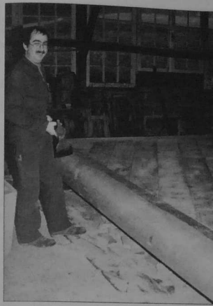
L'arrondi du poteau tourillon d'un vantail de porte d'écluse s'exécute à l'herminette par le charpentier de l'atelier de Saint-Germain-sur-Ille, Jean DEFFAINS, janvier 1989.
