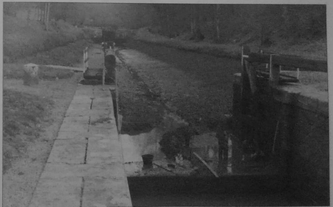
Travaux d'entretien dans les "onze écluses" pendant la période de chômage annuelle par Michel MAUFFRAIS et Thierry EVENS de la brigade de La Roche-Evran. Janvier 1990. On distingue très bien la forme du plafond du canal en double-cuvette.
