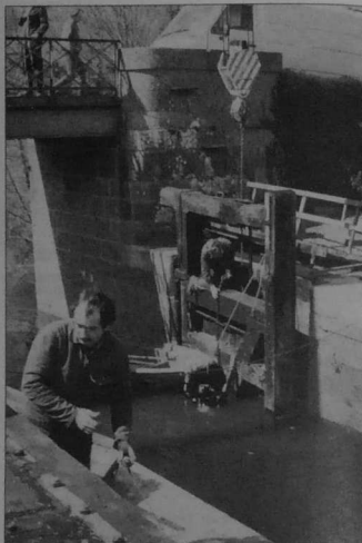
Gros travaux d'entretien : changement de la porte aval, en bois de chêne, à l'écluse de « Pont Perrin » en avril 1990. Au premier plan, Jean DEFFAINS et sur la porte, Jean-Pierre MOULIN. On a fait appel à un plongeur ce qui évite de vider le bief pendant cette opération.
