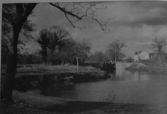
Aire de retournement située en aval de l'écluse de "Gacet" sur la commune de Betton (gare d'évitement)
