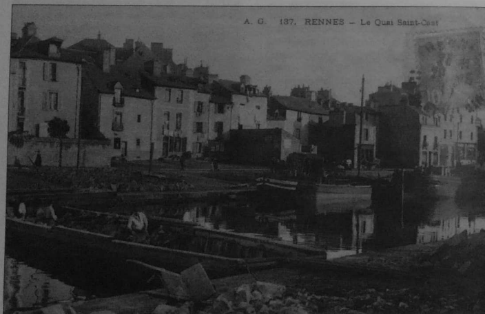
"Port des malouins" à Rennes, à la fin du 19 ème siècle. Sur cette vue, un gabarit de Pont-Réan est déchargé de ses pierres "à coup de brouette" sur le quai d'Ille et Rance. Sur le quai Saint-Cast, sont aussi déposées des pierres. Un chaland nantais (2 moustaches blanches) assure un transit en messagerie. Derrière lui, un chaland de Rance vient d'arriver et attend de pouvoir accoster.
