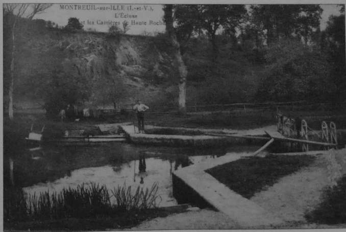
Ecluse de Haute-Roche en 1921. L'écluseur Amédée DUVAL est sur le musoir. On distingue très bien les "béquilles" montées sur les deux vantaux de la porte amont (métallique). Au fond la carrière exploitée par périodes, de manière artisanale.
