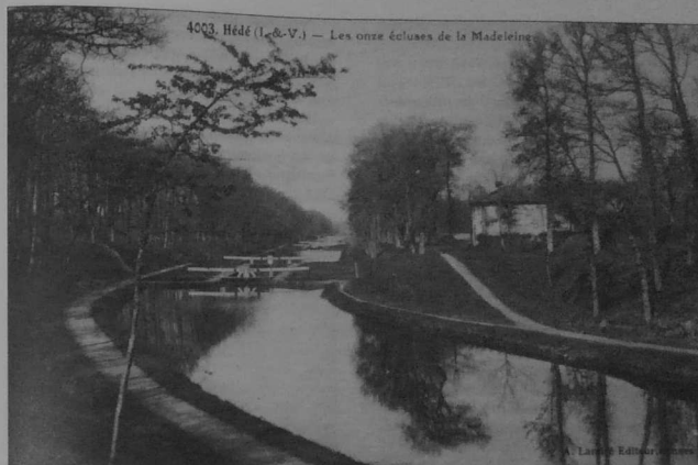
Un lieu remarquable et très beau : les onze écluses de Bazouges-sous-Hédé ! En premier plan, l'écluse n°22 dont on voit très bien les parties de ses portes hautes blanches, comme toutes les autres, au début du 20 ème siècle encore.
