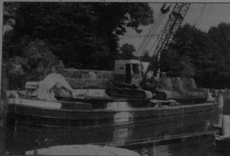
Automoteur "La Paix" à l'entreprise Bernard LECHAT, aménagé pour les travaux spéciaux sur le canal ou la Vilaine. Ici, le 9 juin 1989 à l'écluse de "Macaire" sur la Vilaine.
