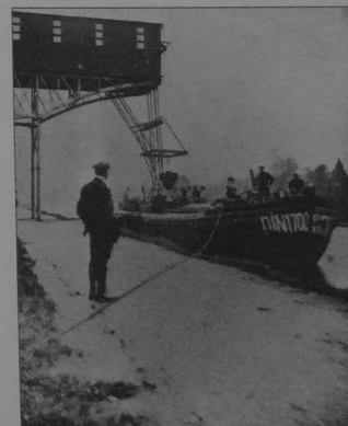
Appontement de l'usine à gaz de Rennes vers 1914. Le chaland "Alfred-Marie", à la compagnie, du gaz est en cours de déchargement sous la surveillance de la hiérarchie. Dix hommes, au moins procèdent au chargement des bennes mécaniques.
