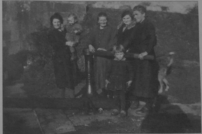
Vue prise en 1934 à l'écluse de Mottay, autour du tourniquet monobloc qui commandait l'ouverture du vantail (côté est) de la porte aval. Une forte barre de bois, enmanchée en tête, permettait de tourner l'ensemble dont les dents, situées au pied, entraînaient la longue et lourde crémaillère assujettie au vantail. Au fond, on distingue les premières pierres du pont attenant. A gauche, Lucie L'HERMITTE épouse FAISANT, future éclusière du lieu, dans ses bras sa fille Annick qui devint aussi éclusière. A suivre, Madame GUERIN épouse du meunier du moulin de Mottay depuis 1931. Au premier plan, Roger, un frère de Annick.
