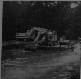
Travaux de dragage sur le canal d'Ille et Rance. On remarque l'horizontalité du godet travaillant sur un fond en forme de cuvette ce qui ne semble pas un bon procédé. Août 1983.
