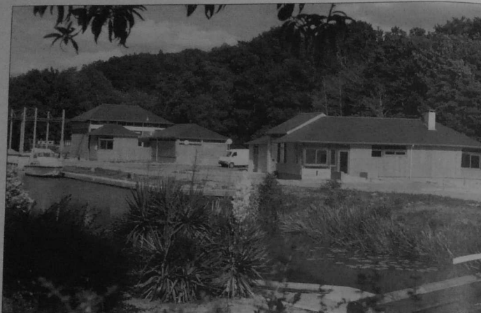
Nouveaux ateliers modernes construits en 1992 à Saint-Germain-sur-Ille. Par l'institution du C.I.R.M.O.N.
