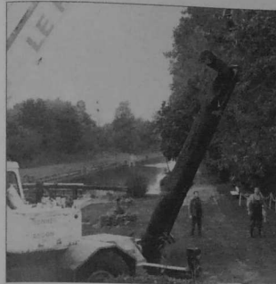
Levage d'une porte en cours de dépose à l'écluse de Gaget-Trevoisien en 1988. Au fond à gauche Alain POIRIER puis Marcel BUREL.
