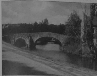
Pont de Léhon. Arche reconstruite sur le même modèle que celui de Dinan dès 1923-24.
