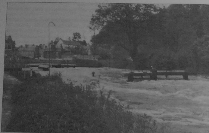
Crue du mercredi 13 mai 1981 à l'écluse de Léhon, tenue par Annick FAISANT (épouse COLLET). L'écluse est complètement submergée. Seul, le haut des portes est encore visible !
