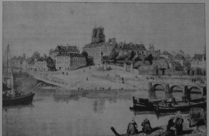
Extension du Port St Yves et embouchure du canal (à gauche, derrière le bateau) vue relevée vers 1830.
