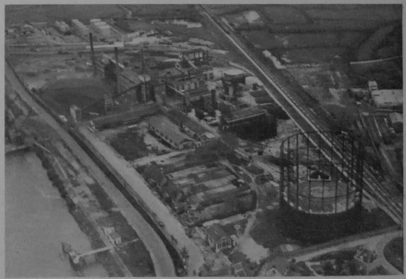
Vue d'ensemble de l'usine à gaz de Roche-Maurice, à Nantes.
