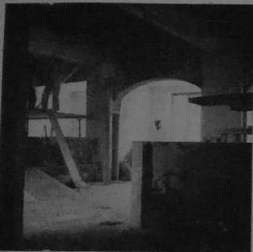
Ateliers aménagés dans le stand de tir.
