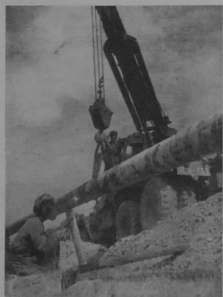
Soudure d'une canalisation de transport de gaz.
