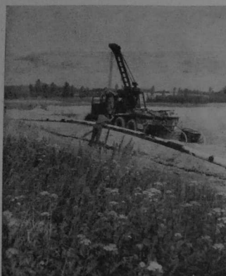
Mise en place d'une canalisation de transport de gaz.
