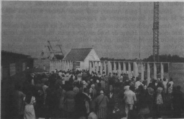
Photo de l'oratoire en construction
