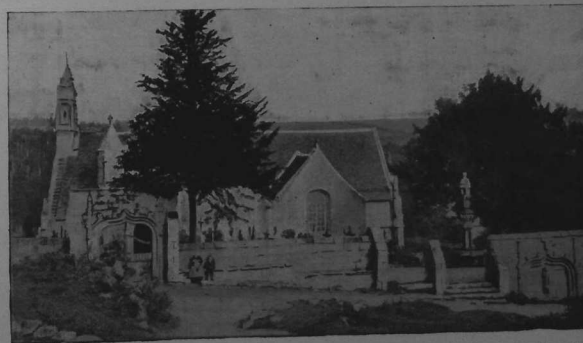
L'ÉGLISE QUI MENACE RUINE : LOGUIVY-LÈS-LANNION
