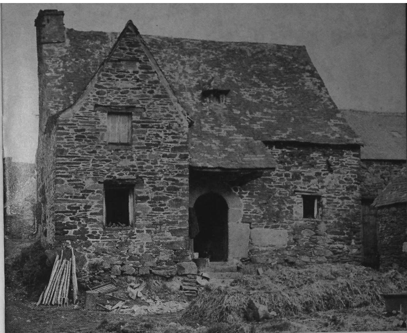
Brasparts : maison à Kerivar'h. Un bon exemple d'apothéïs dans le centre du Finistère. Remarquez les contrastes : dimensions des pierres d'entourage de la porte, le toit sans presque aucun accident. L'auvent n'a pas l'air d'avoir été rajouté après coup. Toute la qualité de cet exemple est dans ses proportions.
