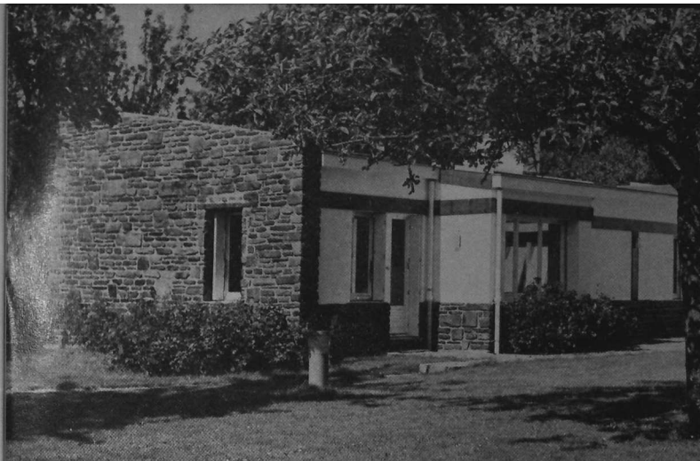
Cléden-Poher : Une toiture à faible pente dans le paysage horizontal d'un verger. Le schiste du pays réutilisé.
