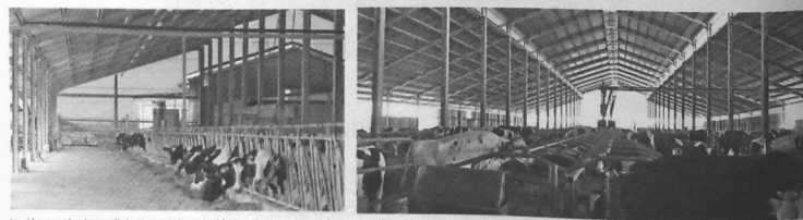
> Un grand volume d'air et une toiture isolée permettent de protéger de la chaleur.
