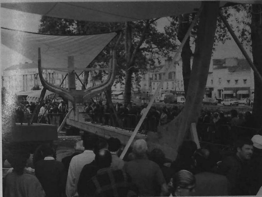
Fête du 23 juin : les ouvriers du chantiers posent la quille, l'étrave et l'étambot, puis les premières membrures
