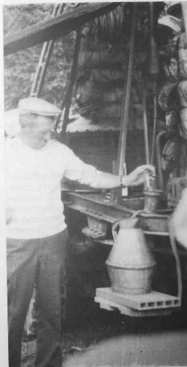
Le pèse-goutte indique le degré de l'eau de vie.
