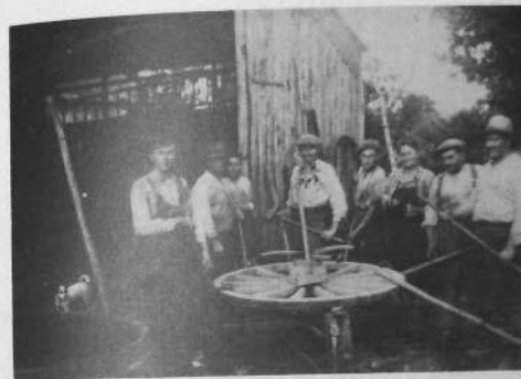
Ferrage d'une roue. A gauche, M. Brillat de Combourtilé.
