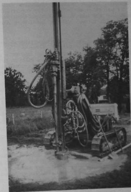
La foreuse en place, avec le compresseur au second plan.
