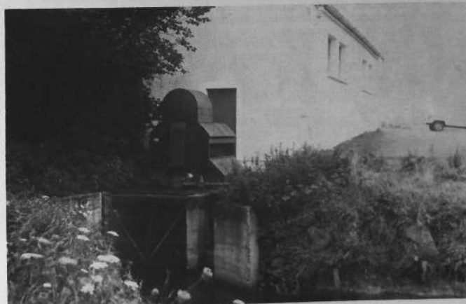
Prise d'eau de station de pompage d'irrigation dans le Léon (Photo J. Querellou)
