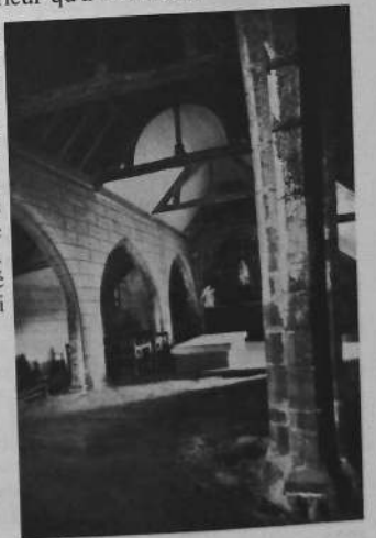
PLOEMEL - Chapelle de Locmaria L'intérieur avant restauration (cliché Arch. Dep. Morbihan)
