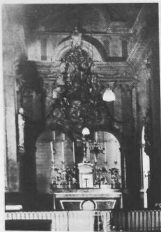
ÉTEL - Le décor du chœur, avant restauration.
