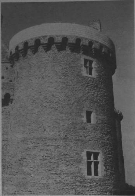
Une « restauration » controversée : le couronnement de la Tour Sud-Est de Suscinio.
