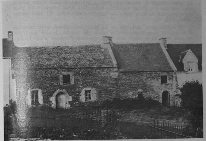
Fig. 3. — Sarzeau, Trevenasté. Exemple de maisons dont le mur de façade a été surhaussé pour changement de matériau de couverture.
