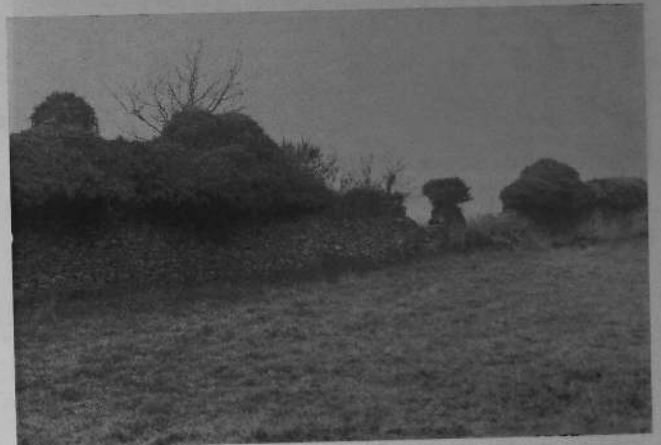
Aspect actuel du mur de clôture du XIII e siècle
