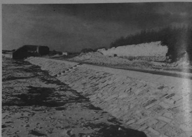
Penvins. La côte recule : déchaussement du mur de propriété malgré la protection artificielle, blockhaus sur la plage.
