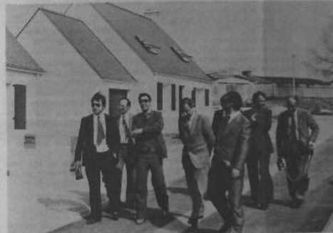
Monsieur MADOUJ Wali d'Annaba et ses collaborateurs visitent le chantier de la Villa génoise de l'entreprise Jegat en compagnie de Monsieur Le Borgne, Maire d'Hennebont, Claude Jegat, Bernard Boclé.
