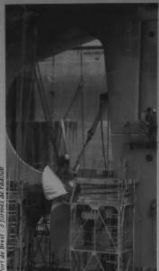
Port de Brest : 3 formes de radoub.
