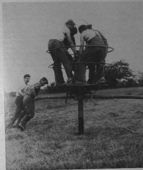
Fig. 39. — Exploration des alluvions à la sondeuse Banka.
