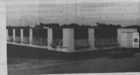
L'installation de la S.I.L.M.M. à Quéven.
