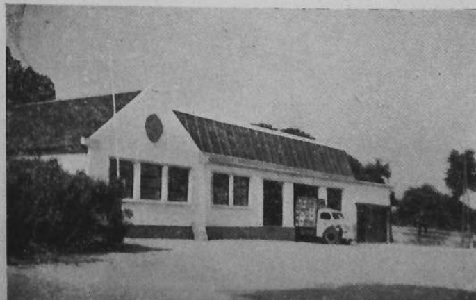
Vue du bâtiment principal
