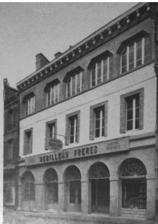
Solidement appuyée sur ses arcades du XVIII e siècle, la Quincaillerie Sébilleau Frères est placée au centre de la rue commerçante de Saint-Brieuc
