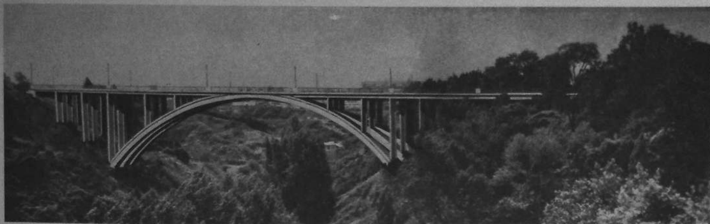
Le pont franchissant le Gouëdic tel qu'il apparaîtra en 1962.
