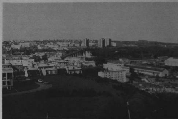
Fig. 3. — Vue prise en direction de l'Ouest. — Au premier plan : Installations industrielles de la Marine Nationale dans la vallée de la Penfeld - Pont de l'Harteloire. — Au second plan : Plateau de Quéliverzan (50 m) avec les tours H.L.M. — En arrière : Plateau de Saint-Pierre (90 m) avec la butte du Polygone dominant les baraques.
