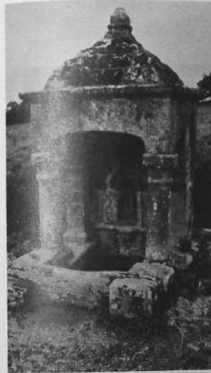
NOYALO — Fontaine de la route de Surzur (1760).
