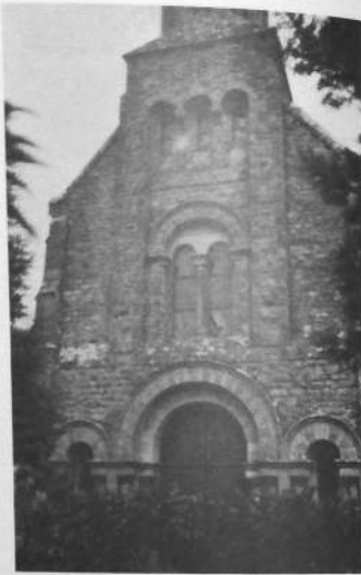
LA TRINITÉ-SURZUR — Façade tour (1901). (cl. Le Corguillé).
