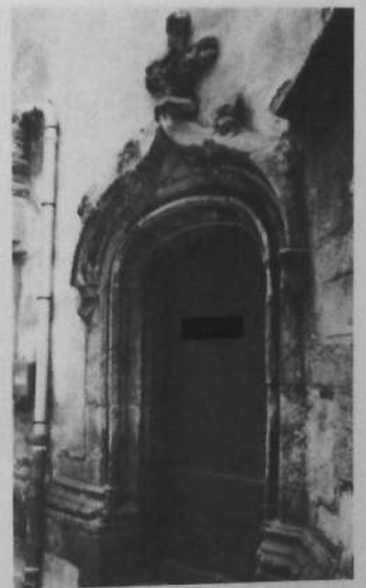
SURZUR — Porte occidentale de la chapelle. Sacristie.
