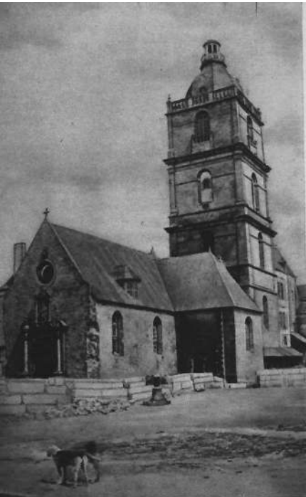
L'ancienne tour carrée.
