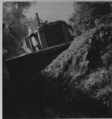
Fig. 2. — Un bulldozer en action
