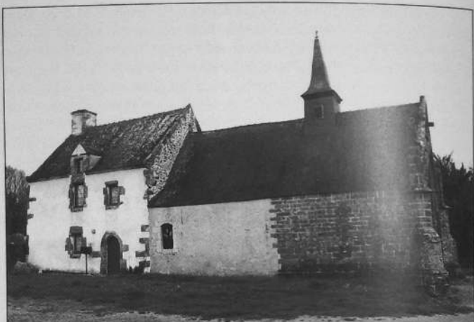
Chapelle de Brouel, façade occidentale
