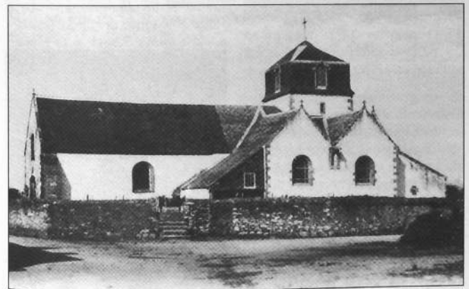
L'église avant la restauration du clocher
