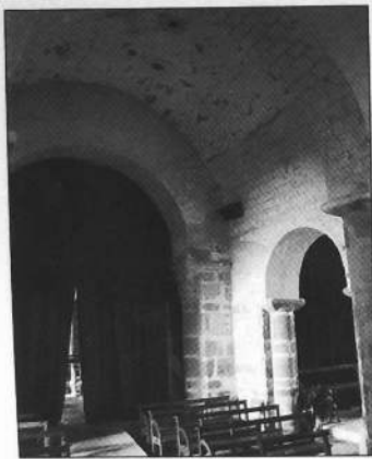
La croisée du transept.
