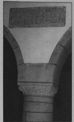
Pile médiane de la chapelle du midi
