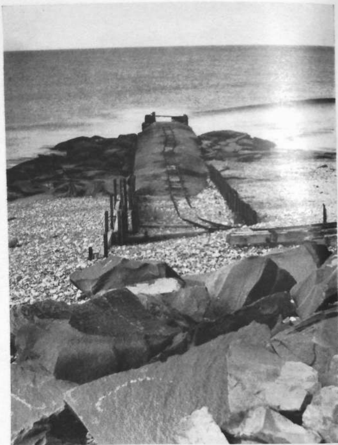
Arweinir Afon Dysynni (Sir Feirionnydd) i'r môr drwy'r twnel concrit a welir uchod. (Wyddoch chi pam? Holwch am lefel yr afon.) Rhwystrir y twnel rhag cael ei falu gan donnau trwy osod cannoedd o dunelli o gerrig mawrion bob ochr iddo. Oherwydd bod y cerrig yn suddo rhaid gwneud hyn bob dwy flynedd.
