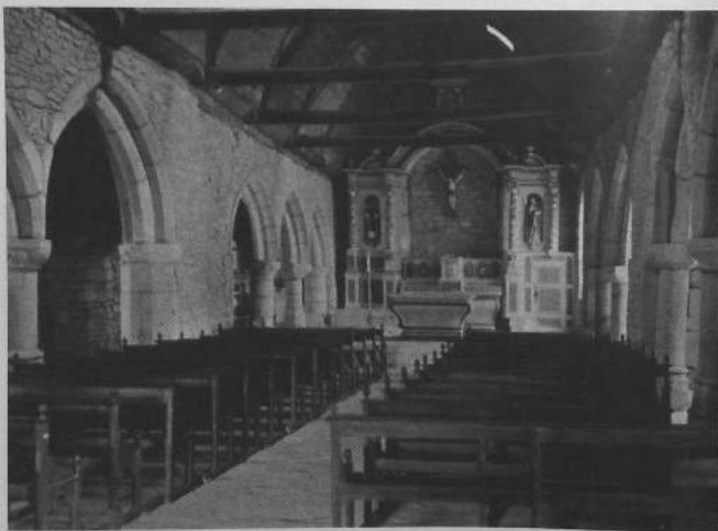
Église. Nef centrale restaurée en 1969.
